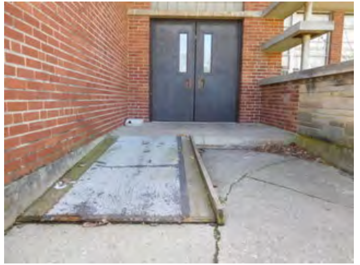
ADA Access Ramp
