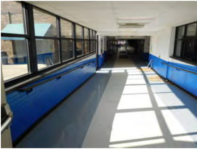
ADA Compliant Ramp
